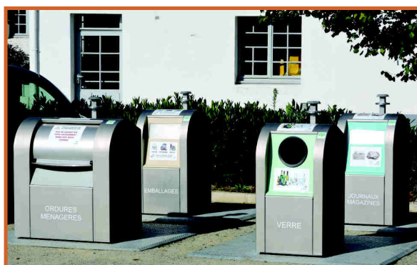
Containers enterrés - Place de la Poste
